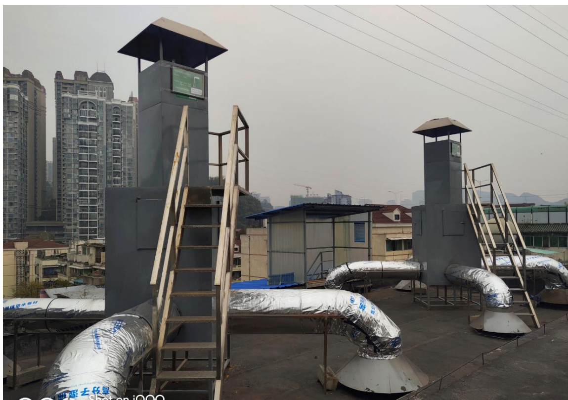
在楼顶 1#、2#排气筒
