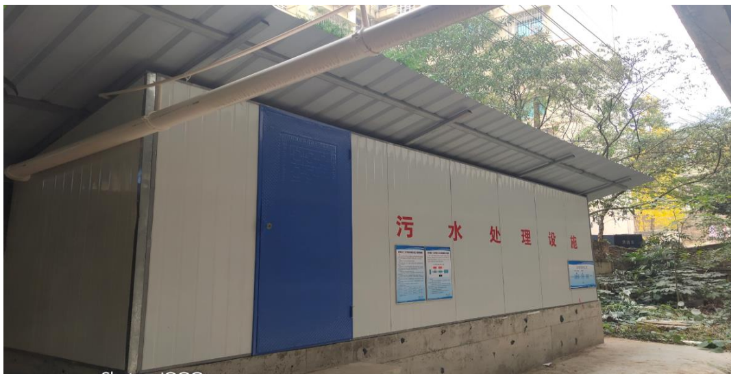
贵州省化工研究院建设的调节池、沉淀池处理设施
