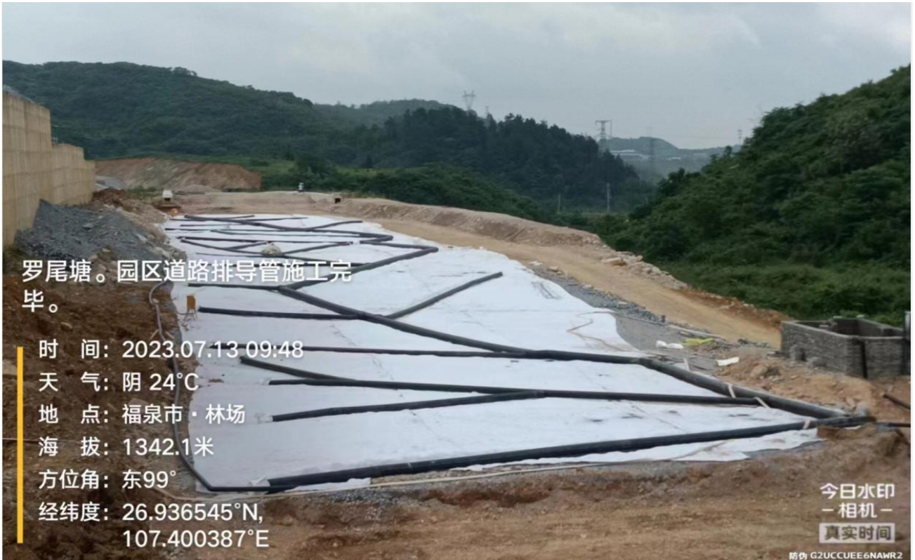
导排盲管建设
