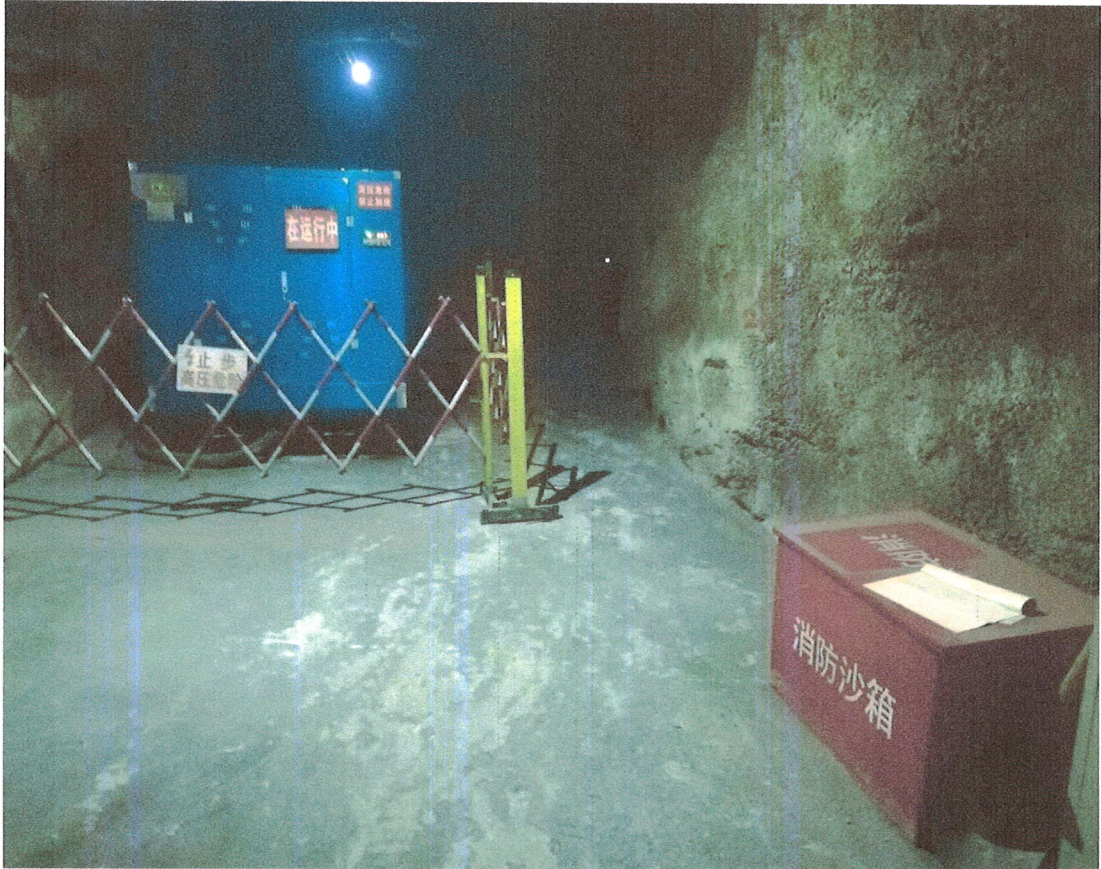
井下勘察照片（一）
