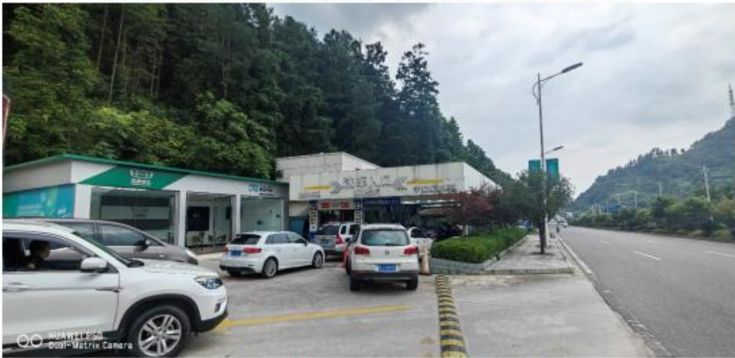
现场照片（站区辅助房含卫生间及发电间）
