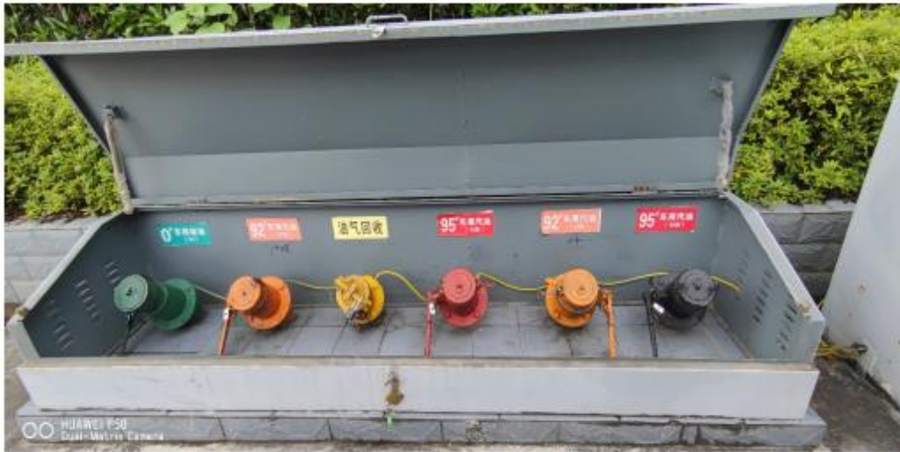
现场照片（密闭卸油口）
