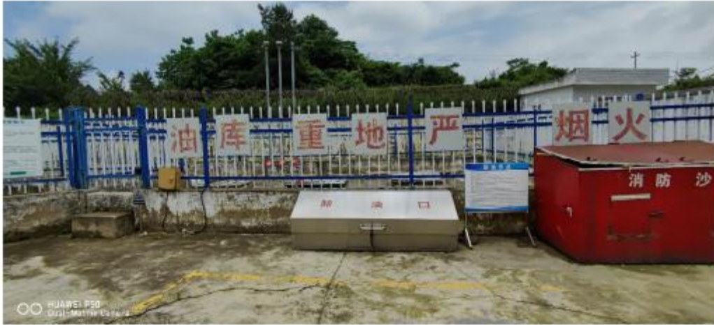
现场照片（加油站卸油口）
