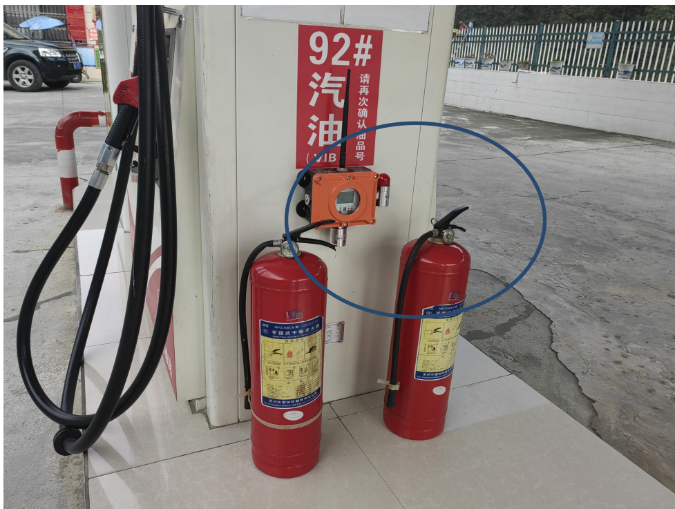
已设置可燃气体检测报警装置
